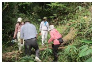
倒木の撤去作業
