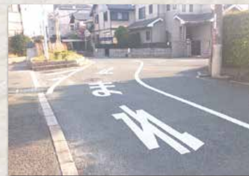
星丘駅から村野駅方面に向かう変則交差点での路面表示強化等安全対策での改良
