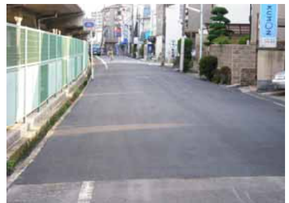
牧野阪1丁目の道路補修整備
